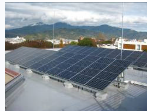
太陽光発電装置の設置(県立美術館)
