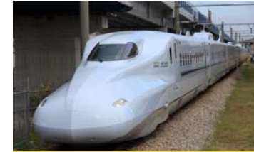
九州新幹線は平成23年3月12日に全線開業しました。
