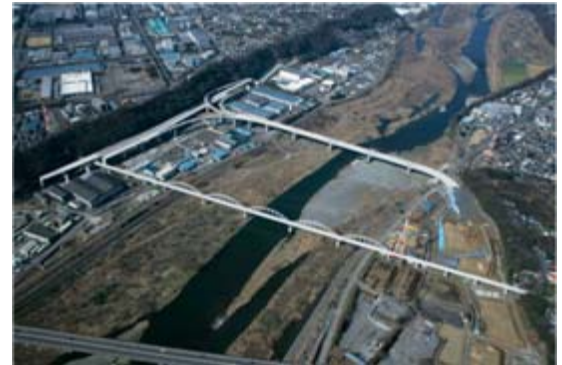
＜さがみ縦貫道路 建設中の（仮称）相模原I.C.＞
