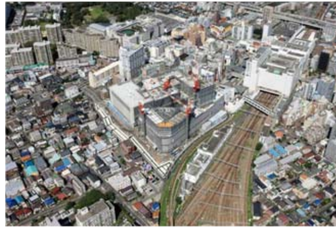
〈相模大野駅と建設が進む西側地区再開発事業〉
