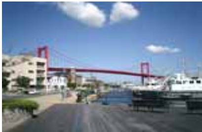
若松と戸畑を結ぶ 若戸大橋
