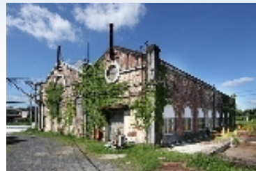
遠賀川水源地ポンプ室 〔非公開施設〕写真提供／ 新日鐵住金(株)八幡製鐵所
