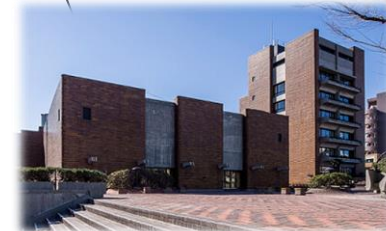
大規模改修後の埼玉会館（県立文化会館）
