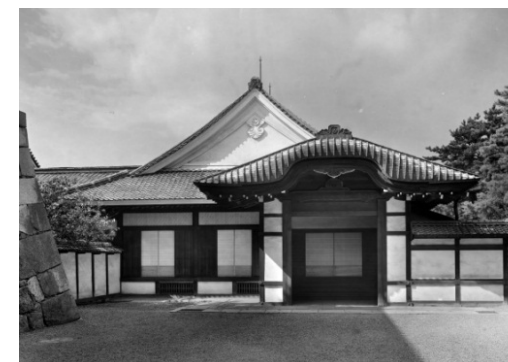
戦災焼失前の名古屋城本丸御殿 玄関・車寄
