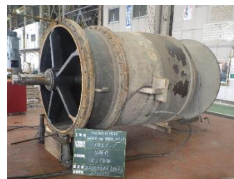
整備前の排水機
