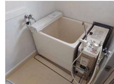
県営住宅浴槽・風呂釜設置工事
