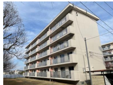
県営住宅外壁改修工事
