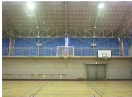
体育館の耐震化 (ブレース補強)
