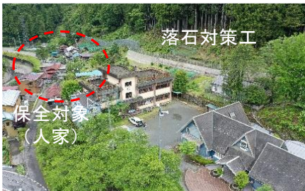
砂防関係施設整備
