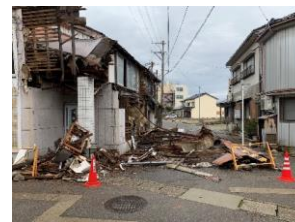
倒壊した家屋（氷見市）
