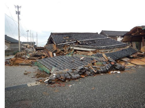
旧角海家住宅（輪島市）の被害
