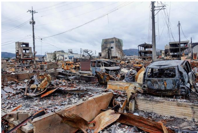
輪島市内の火災被害
