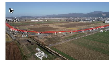
福井港丸岡インター連絡道路
