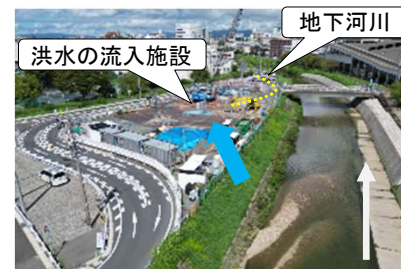
河川海岸整備
