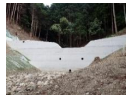
治山ダムの整備
