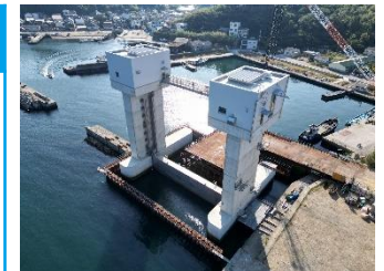
沼島漁港 水門整備
