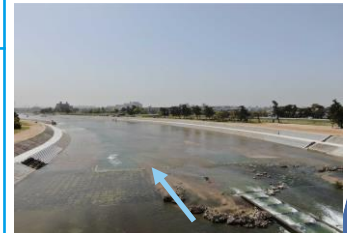
武庫川 河川改修
