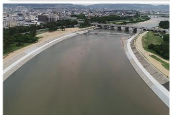
武庫川 護岸工事(尼崎市・西宮市)
