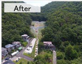
治山ダムの整備 (三田市上青野地区)
