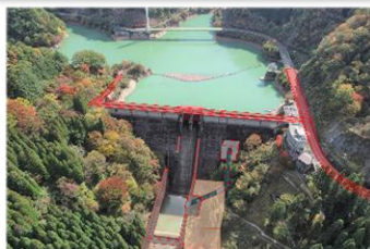
引原ダム(夙粟市)
