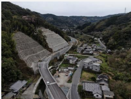
緊急輸送道路整備・法面対策事業
