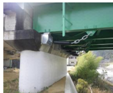
落橋防止の設置
