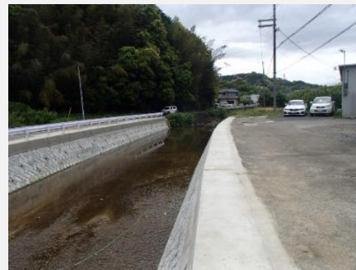
河川修繕・堤防改修事業
