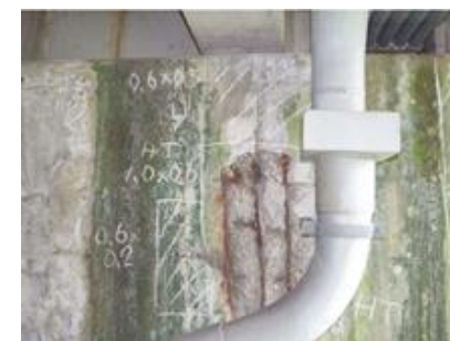
コンクリートの剥離 (橋脚) の補修
