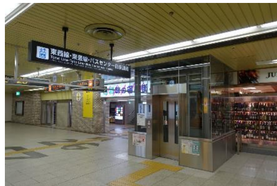
▲ バリアフリーエレベーター設置例(地下)
