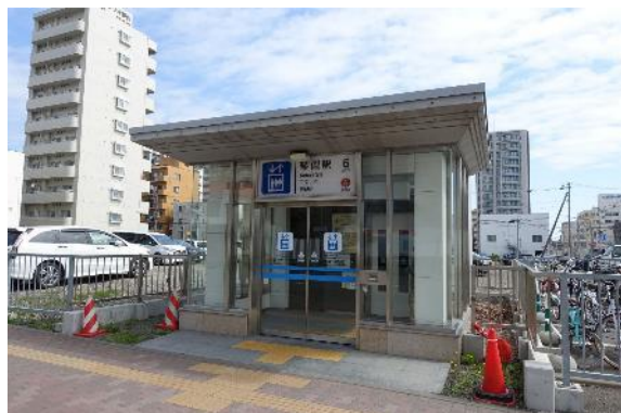
▲ バリアフリーエレベーター設置例(地上)
