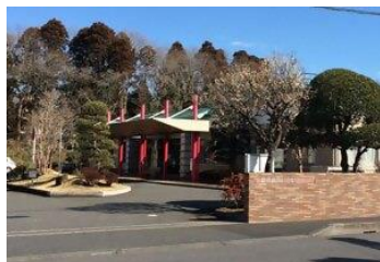
余剰電力活用例① 若葉いきいきプラザ
