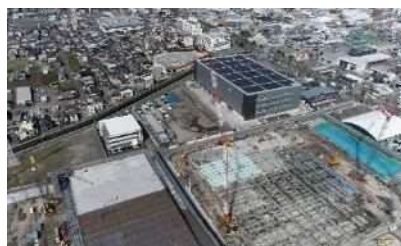
整備中の恩田原・片山エリア
