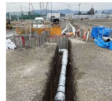
耐震化された水道管への布設替
