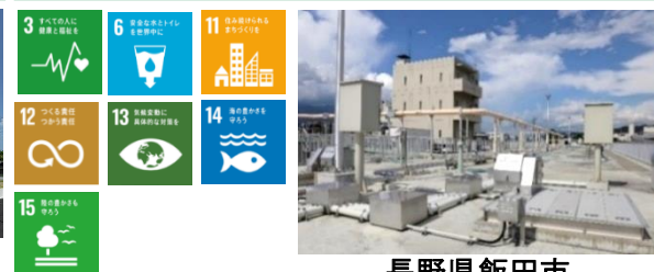
長野県飯田市 松尾浄化管理センター
