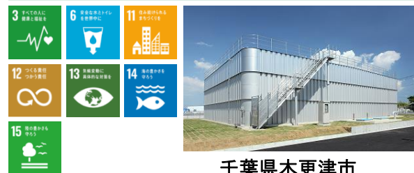
千葉県木更津市 金田配水場
