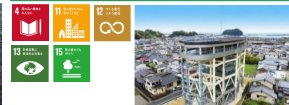
高知県黒潮町 佐賀地区津波避難タワー
